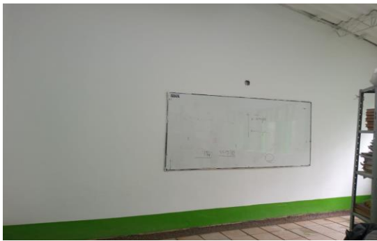
SE REALIZO LA ACTIVIDAD DE APLICACIÓN PINTURA VINILO TIPO 1 Y MEDIA CAÑA EN GRAVILLA LAVADA
