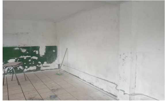
SE REALIZO LA ACTIVIDAD DE PAÑETE, APLICACIÓN ESTUCO Y PINTURA VINILO TIPO 1 EN LA AULA # 5
