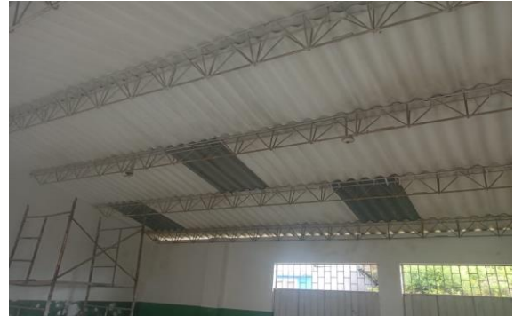
SE REALIZO LA COLOCACION DE RECORRIDO CUBIERTA EN FIBROCEMENTO EN LA AULA #1 Y #2.
