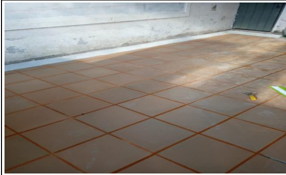
SE REALIZO LA ACTIVIDAD DE COLOCACION DE MEDIA CAÑA EN GRAVILLA LAVADA EN EL AREA DE ENFERMERIA, SALA DE PROFESORES Y ADMINISTRACION.
