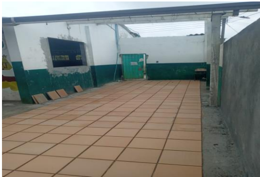
SE REALIZO LA ACTIVIDAD DE COLOCACION BALDOSA GRES EN EL AREA DE COMEDOR.
